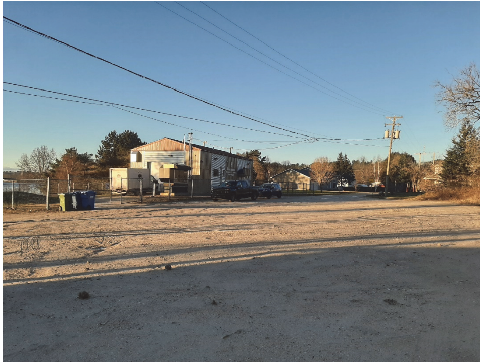
Photo 3 : Aperçu du bâtiment de production d'eau potable – 2021-12-03
